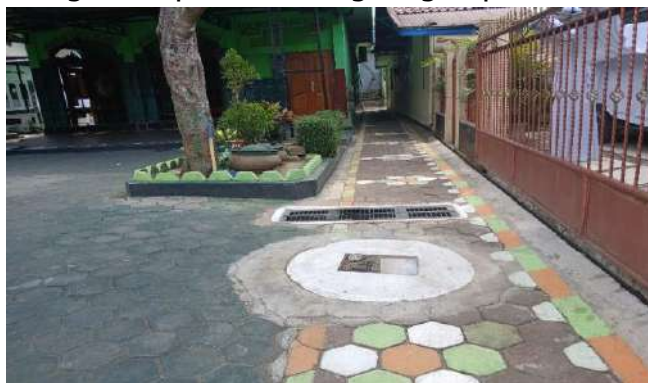
Gambar 2. 69 Sumur Resapan di Kelurahan Wates
