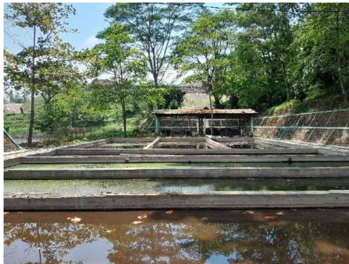
Gambar 2. 73 Kolam Lindi TPSA Banyuurip Kota Magelang Sumber: Dokumentasi, 2025
