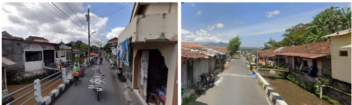
Gambar 2. 11 Citra Bangunan Perumahan Terindikasi Melanggar Sempadan Sungai Permukiman di Bantaran Kali Bening
