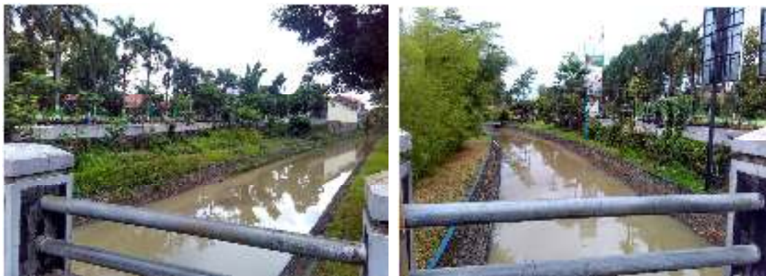
Gambar 3. Saluran Irigasi Kali Manggis
